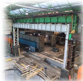
STRUTTURE IN ACCIAIO
