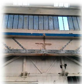
RINFORZI E ADEGUAMENTI
